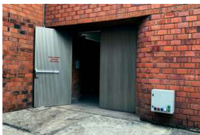
IMAGEN 6 | PUERTA DE INGRESO DESDE ESTACIONAMIENTO
