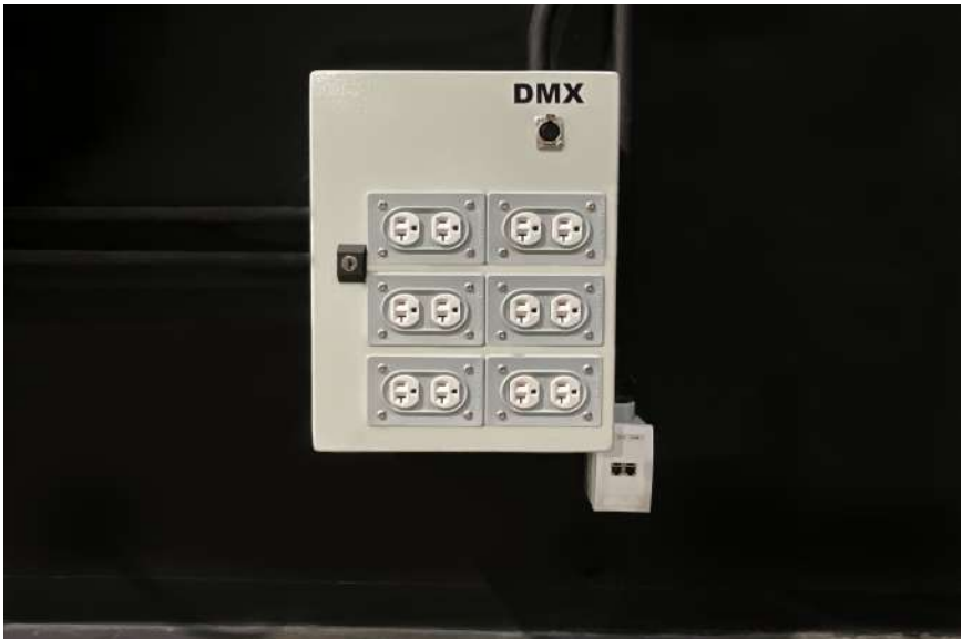
IMAGEN 16| CAJA DE CONEXIÓN ELÉCTRICA EN FORO
